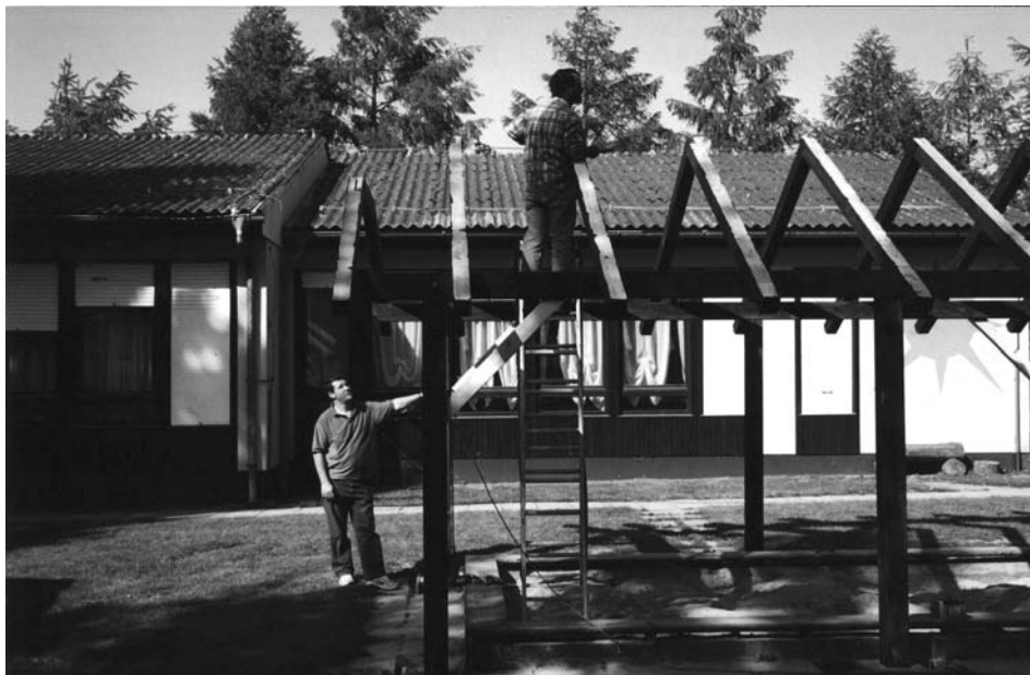
Postavljanje strehe nad peskovnikom (2002).
