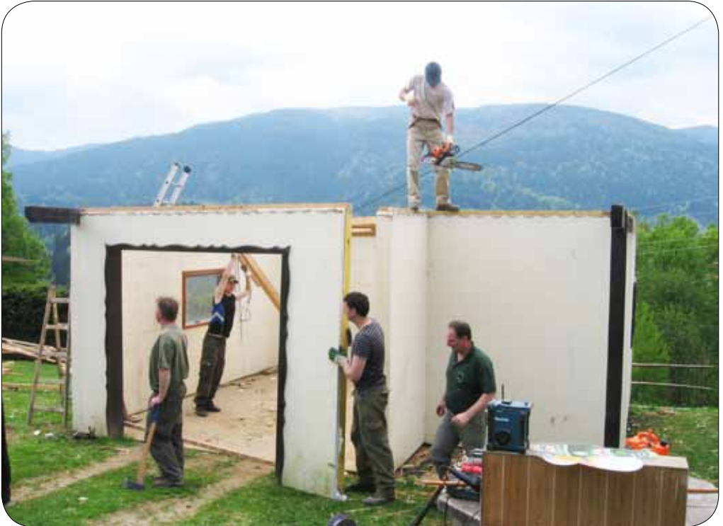
Rušenje starega objekta
